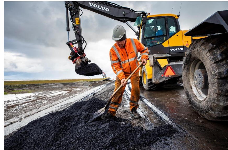
Figuur 4 Lauwersmeerdijk - asfaltering buitentalud
