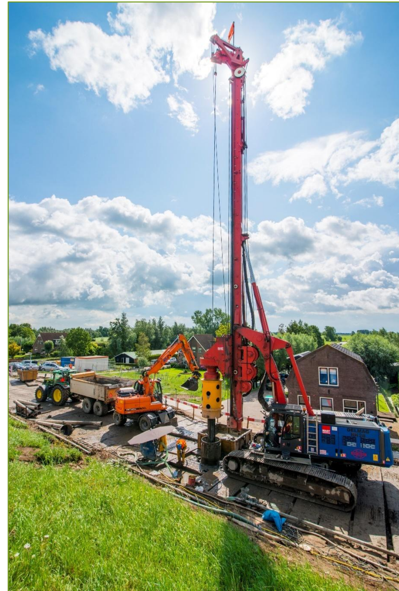
Figuur 3: Plaatsen van boorpalen bij dijkversterking Kinderdijk- Schoonhovenseveer
