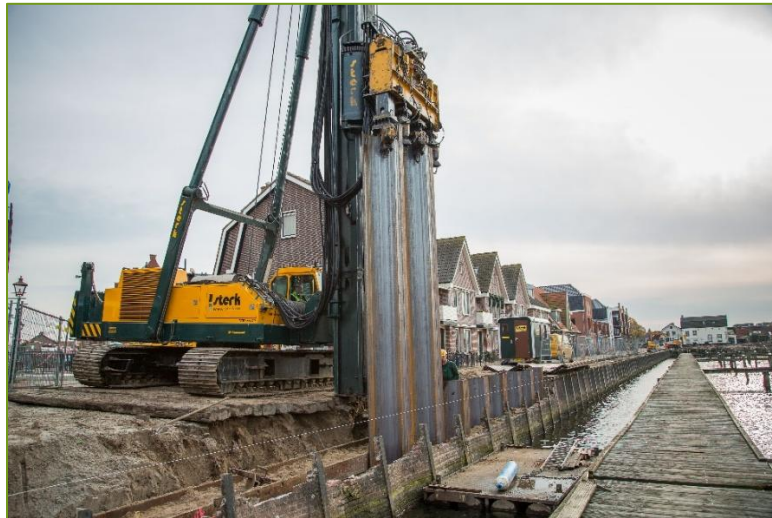
Figuur 9: Aanbrengen van een damwand in Spakenburg.
