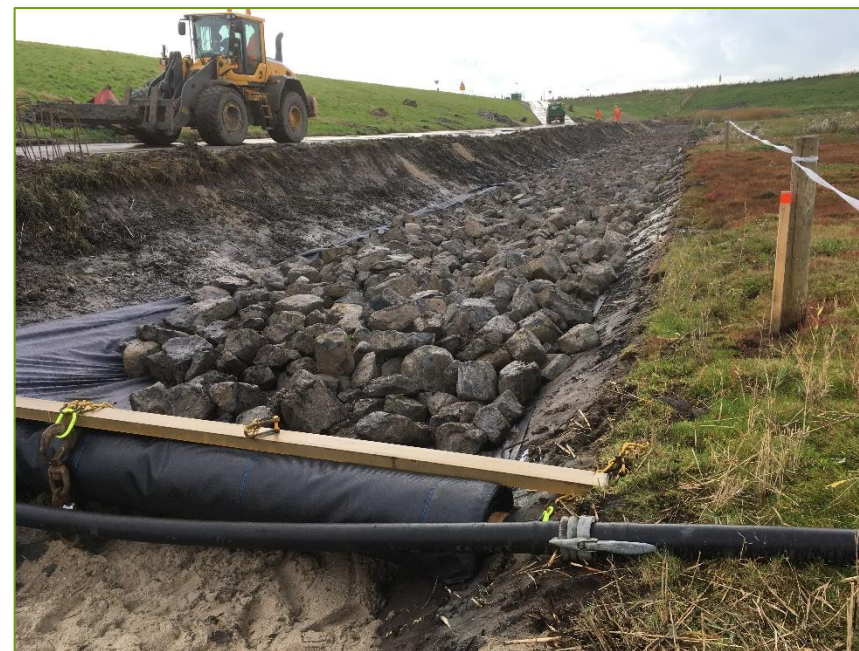
Figuur 12: Geotextiel met daarop breuksteen in Schouwen-Duiveland
