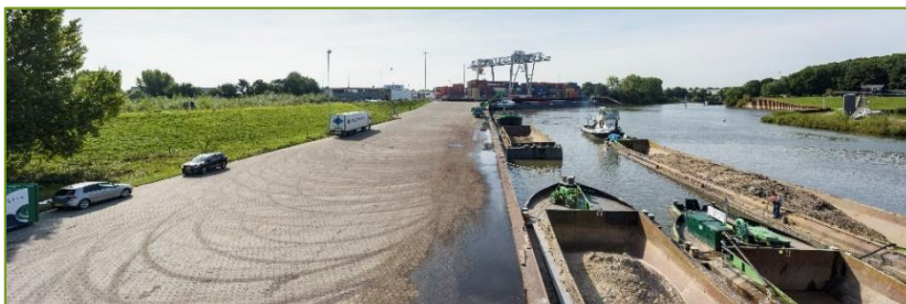
Figuur 6: Transport van zand over water bij dijkversterking
