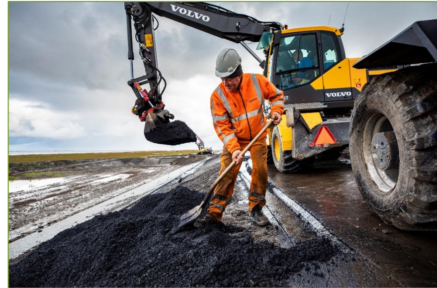
Figuur 13: Asfalteren van het buitentalud van de Lauwersmeerdijk
