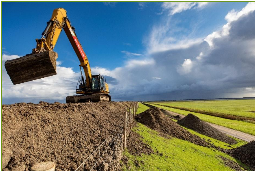
Figuur 7: aanbrengen van klei bij dijkversterking Lauwersmeerdijk
