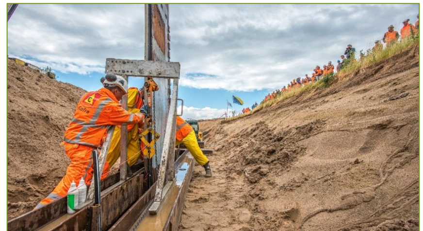
Figuur 11: Aanbrengen van Verticaal Zanddicht Geotextiel (VZG)
