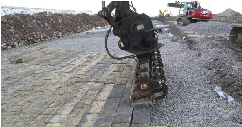
Figuur 8: Aanbrengen van zetsteen als dijkbekleding
