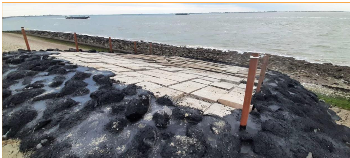
Figuur 32 Proefvak zetsteen van baggerspecie net na aanleg
