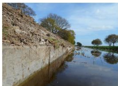
GEOWALL® Kademuur bagger (2015)
