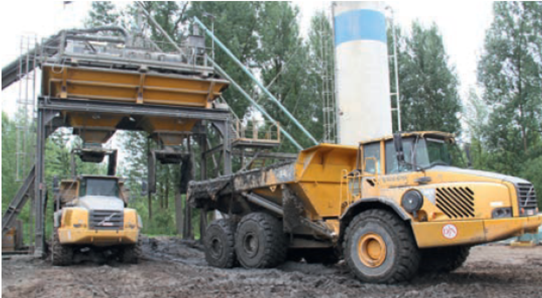
Figuur 3-9: Toevoegen van kalk toegepast bij dijk Vlassenbroekse polder (Terra et Aqua 138, 2015)
