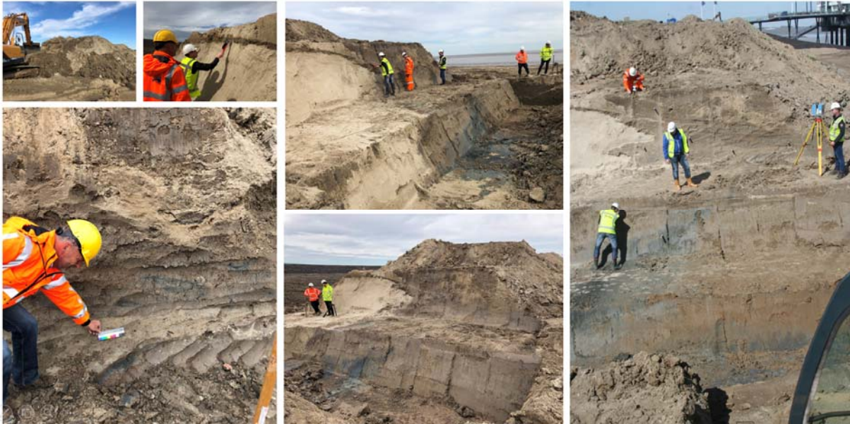
Figuur 1: Impressie inmeetwerkzaamheden kleikern zeedijk Delfzijl, 25 april 2019
