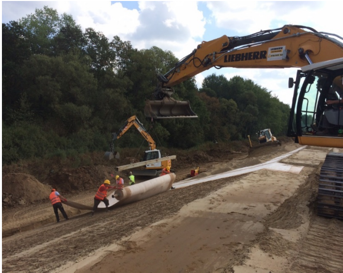
Figuur 13: GCL toepassing deklaag buitentalud, Oderdijk Duitsland, 2018
