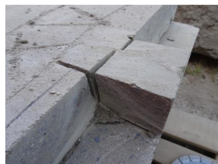
Figuur 3-4 Structuur en oppervlakte van zetsteen van baggerspecie Pilot Hansweert
