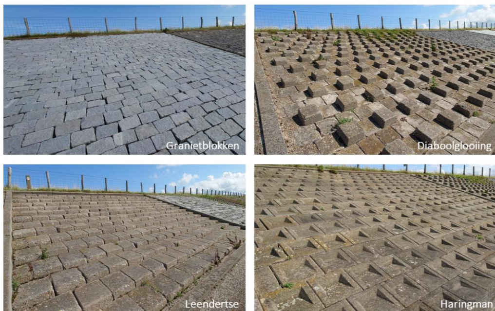
Figuur 5-1 Voorbeelden van eenvoudige vormen zetsteen die gemaakt kunnen worden van baggerspecie blokken
