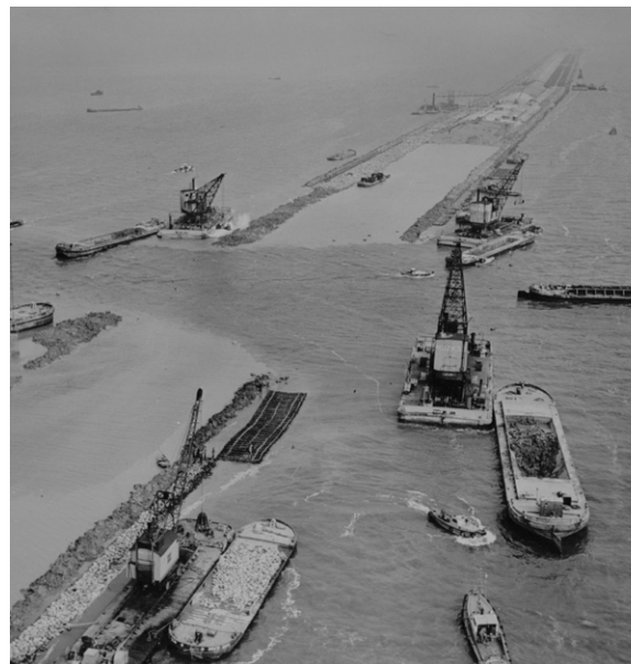
Sluiting van de ringdijk Oostelijk Flevoland. Bron: Beeldbank Rijkswaterstaat
