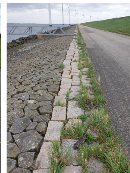
Dijk nabij Ketelbrug (Meerdijk)
