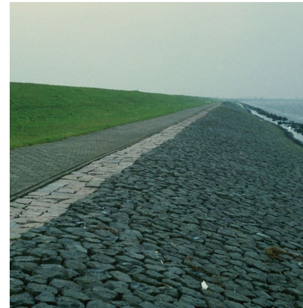
Een beeld van de huidige situatie: de kenmerkende obstakelvrije, oneindige dijken bestaande uit stortsteen en grastaluds (Beeldbank Rijkswaterstaat)
