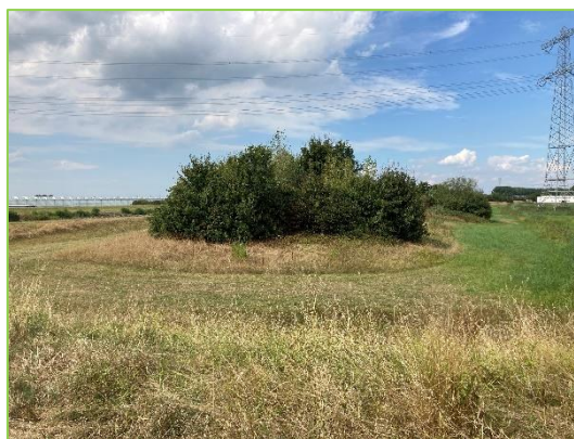
Foto 4 Beplanting in overhoogte op pipingberm
