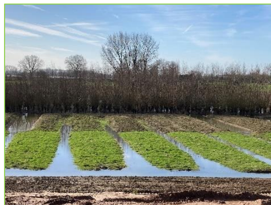
Foto 13 Rabatten achter de waterkering.
