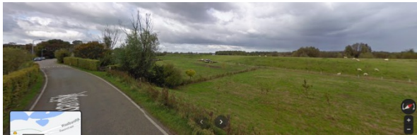
Figuur 2: Vanaf de Waalbandijk zicht op de nieuwe dijk
